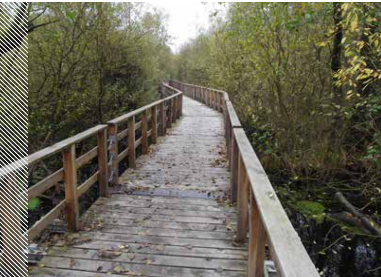
— Abb. 2: Die 320m lange auf Pontons lagernde schwimmende Holzbrücke durchzieht das Moor. Foto. Rolf de Vries
